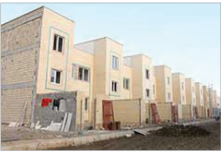
کارگران در حال ساخت مسکن در تهران
